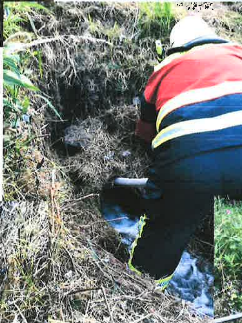
Es floss kaum noch Wasser durch die Rohre
