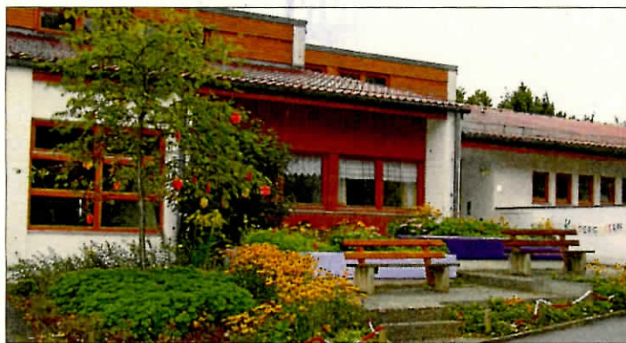
Der Kindergarten St. Andreas erfährt eine umfassende Instandsetzung. (Fotos: Suttner)
